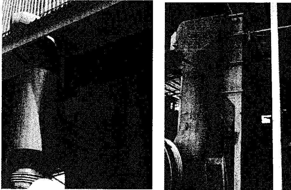
Hình 3-11. Hệ thống lọc bụi tại khu vực nghiền sản phẩm
