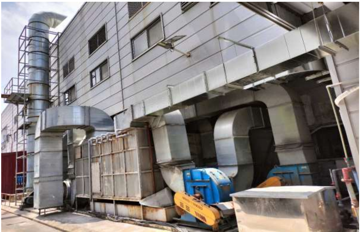
Hình 3.8. Khu vực xử lý hơi dung môi dây chuyền sơn tầng 1
