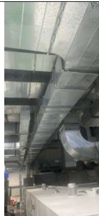
Hệ thống đường hút khí thải trong xưởng
