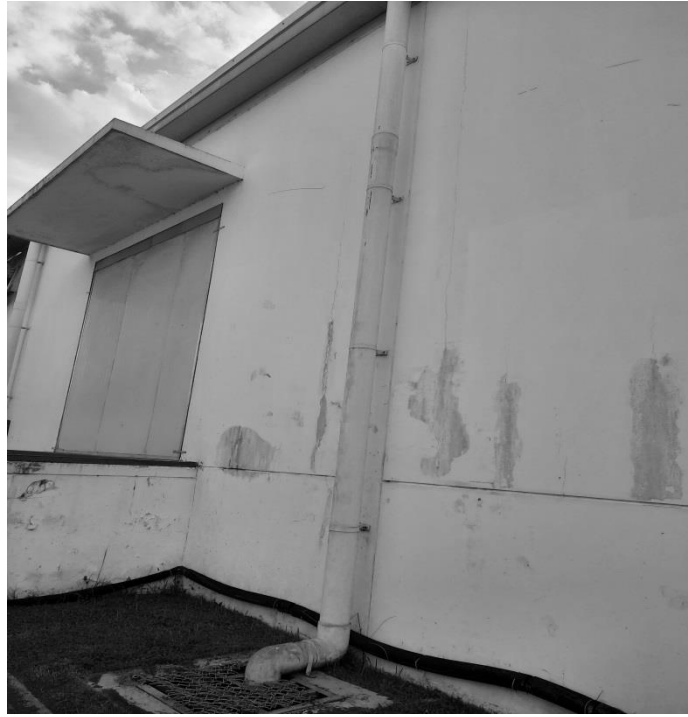
Hình 4.7. Hệ thống thu gom nước mưa
