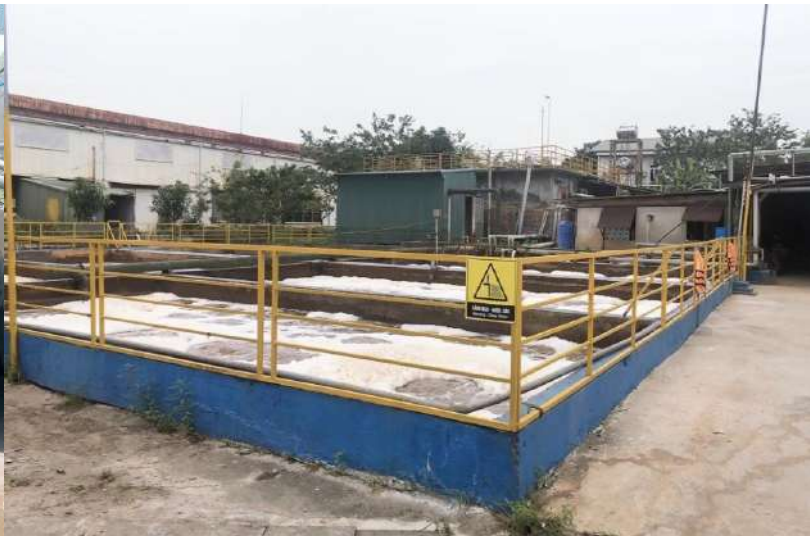
Khu vực hệ thống xử lý nước thải
