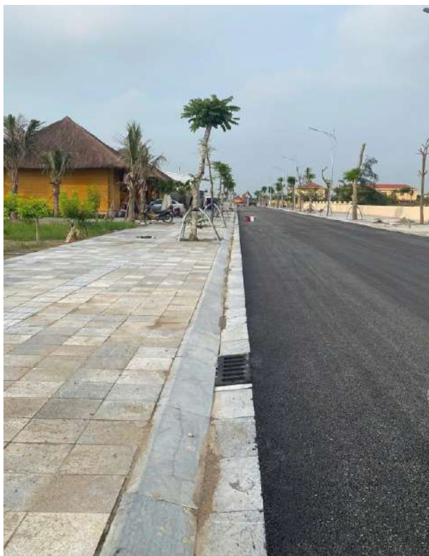
Hệ thống rãnh thoát nước mưa
