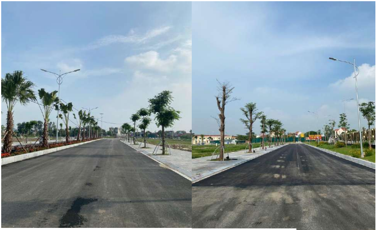
Tuyến đường nội bộ khu vực dự án
